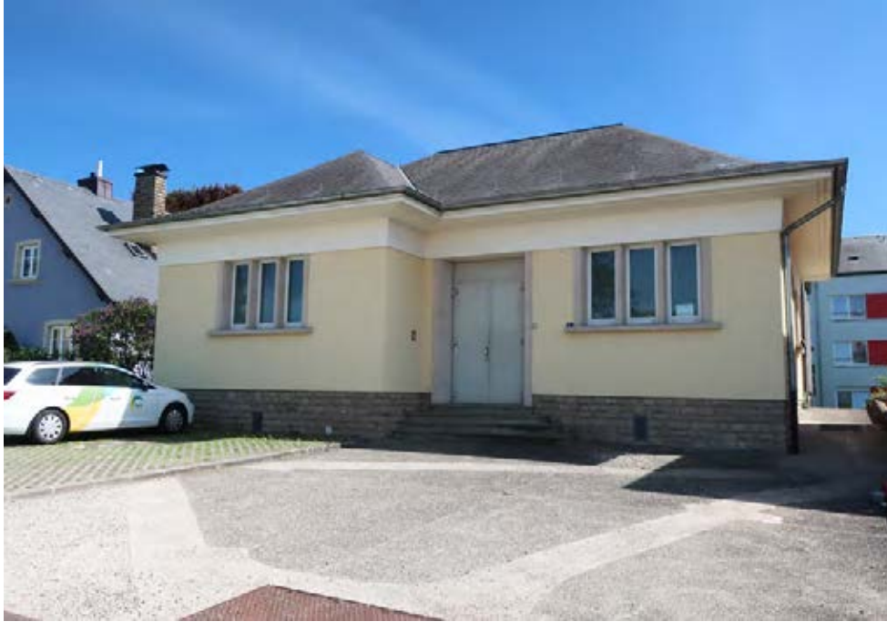
Abb. rechts | (2) Ansicht der Nordseite auf dem Ausführungsplan, 1952 Welter, René, Central téléphonique . Mersch, [Plan], Ausschnitt, Gemeindearchiv Mersch, Luxemburg, 1952.
