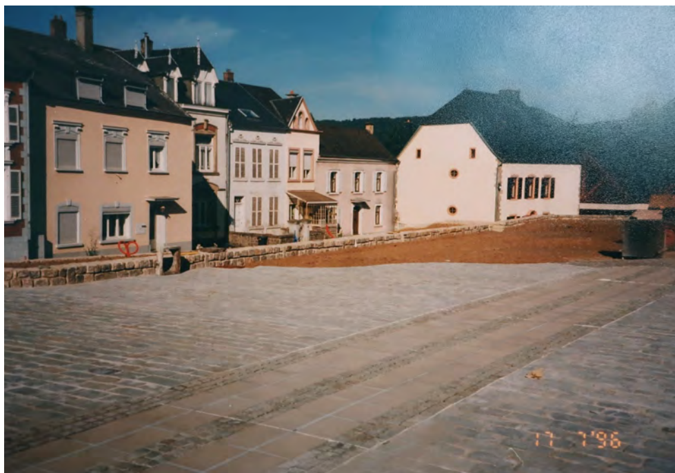
Die Rue Jean Majerus während den Renovierungsarbeiten der Place St. Michel, 1996
