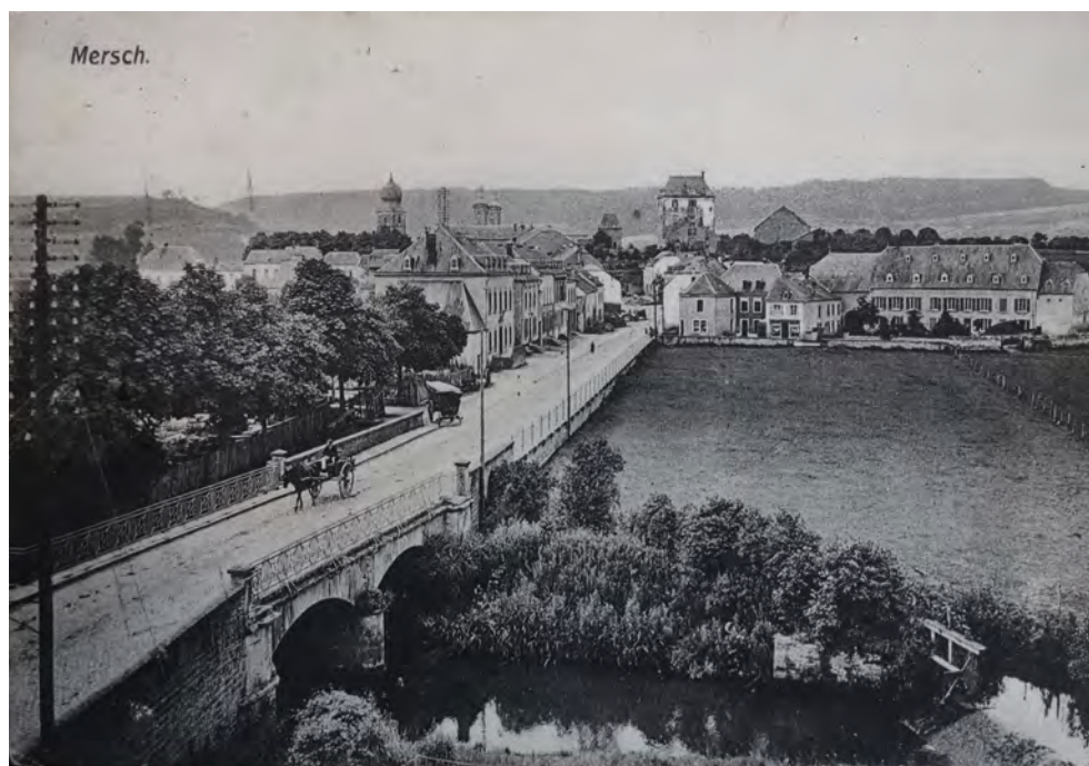
Historische Ansicht der Eischbrücke und der Rue Grande-Duchesse Charlotte
