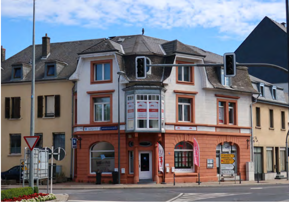
Abb. rechts | (4) Das Anwesen nach Abschluss der Restaurierungsarbeiten, nach 2000
