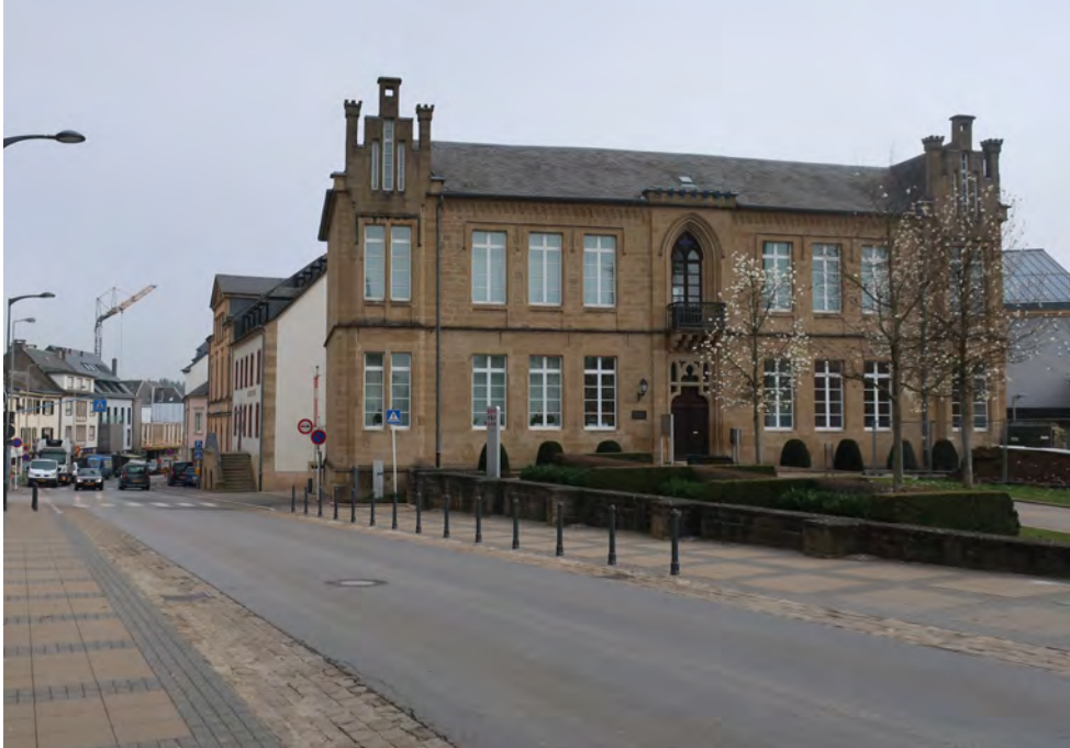
Abb. rechts | (3) Plan des Schulgebäudes, 1938 Crelo, Adolphe, Schulgebäude von Mersch , [Plan], Ausschnitt, Gemeindearchiv Mersch, Luxemburg, 1938.
