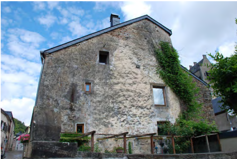
(5) Fassade nach Osten Unregelmäßige Aufteilung und spätmittelalterliche Fensteröffnungen
