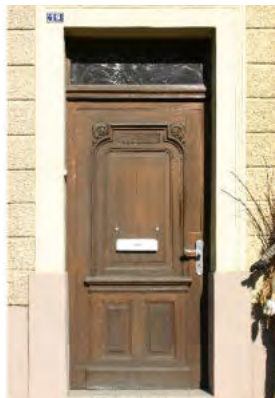
Tür des Eklektizismus 1870-1930 19, rue du Moulin
