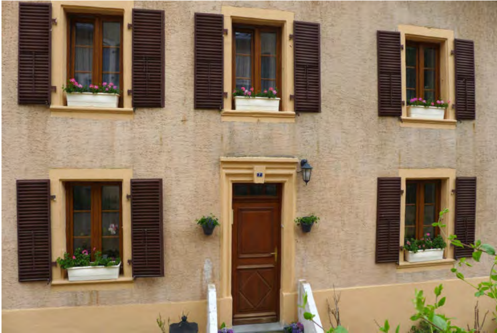
(4) Fassade nach Süden Regelmäßige Aufteilung und klassizistische Formensprache
