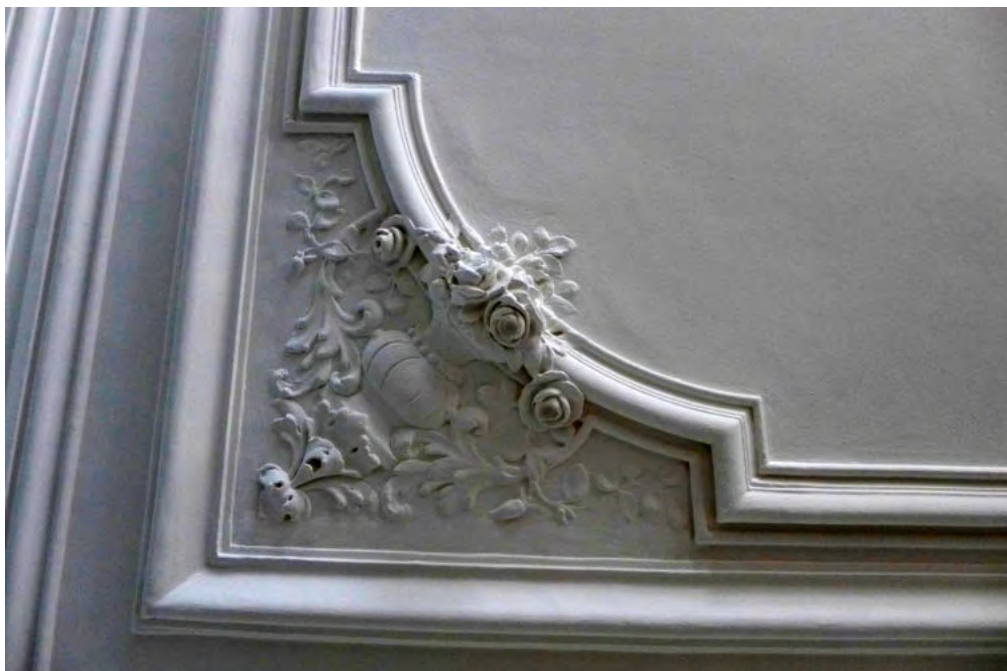
(12) Straßenseitiger großer Raum im Erdgeschoss, 2016 Florale Motive und Blattmaske in den Ecken der Stuckdecke
