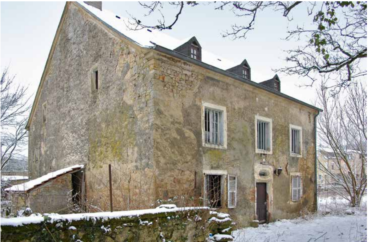
▼ Südfassade vor der umfassenden Renovierung, 2005 Provost, Paul, Haus Herr Route de Fischbach , [Fotografische Aufnahme], Privatsammlung Paul Provost, Lintgen, 2005.
